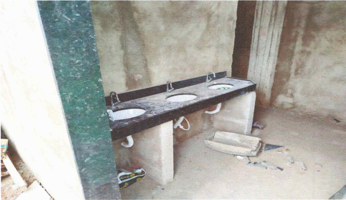
Anexo 02: Quadra poliesportiva do sitio Cachoeira de Minas em construção. Data: 05/04/2024
