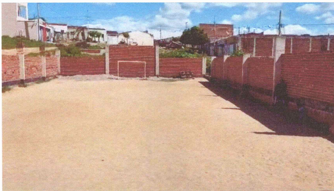
Anexo 03: Quadra poliesportiva do bairro São Francisco em construção. Data: 05/04/2024
