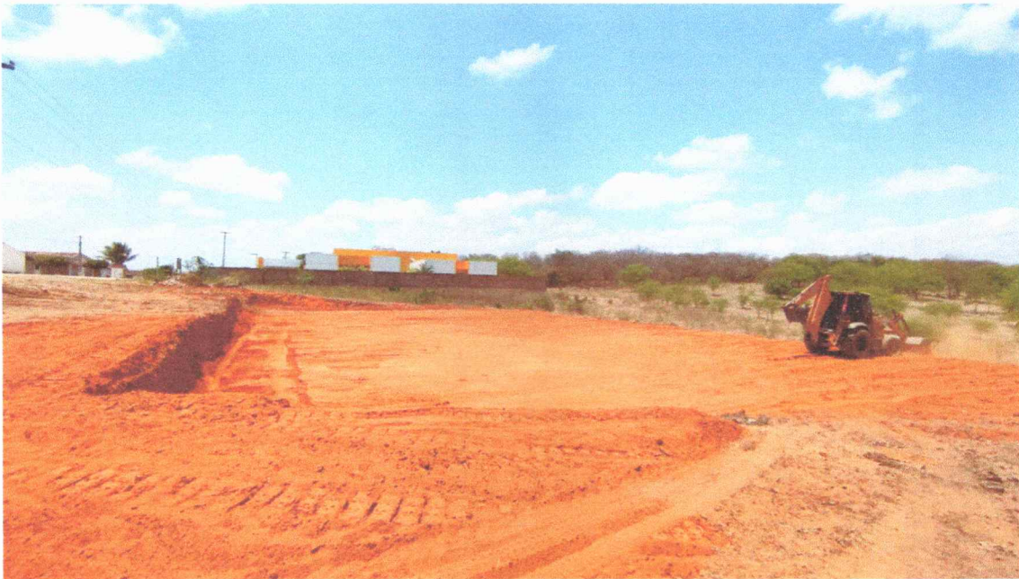
Anexo 01: Terreno para a construção da Quadra poliesportiva do bairro da Várzea. Data: 05/04/2024
