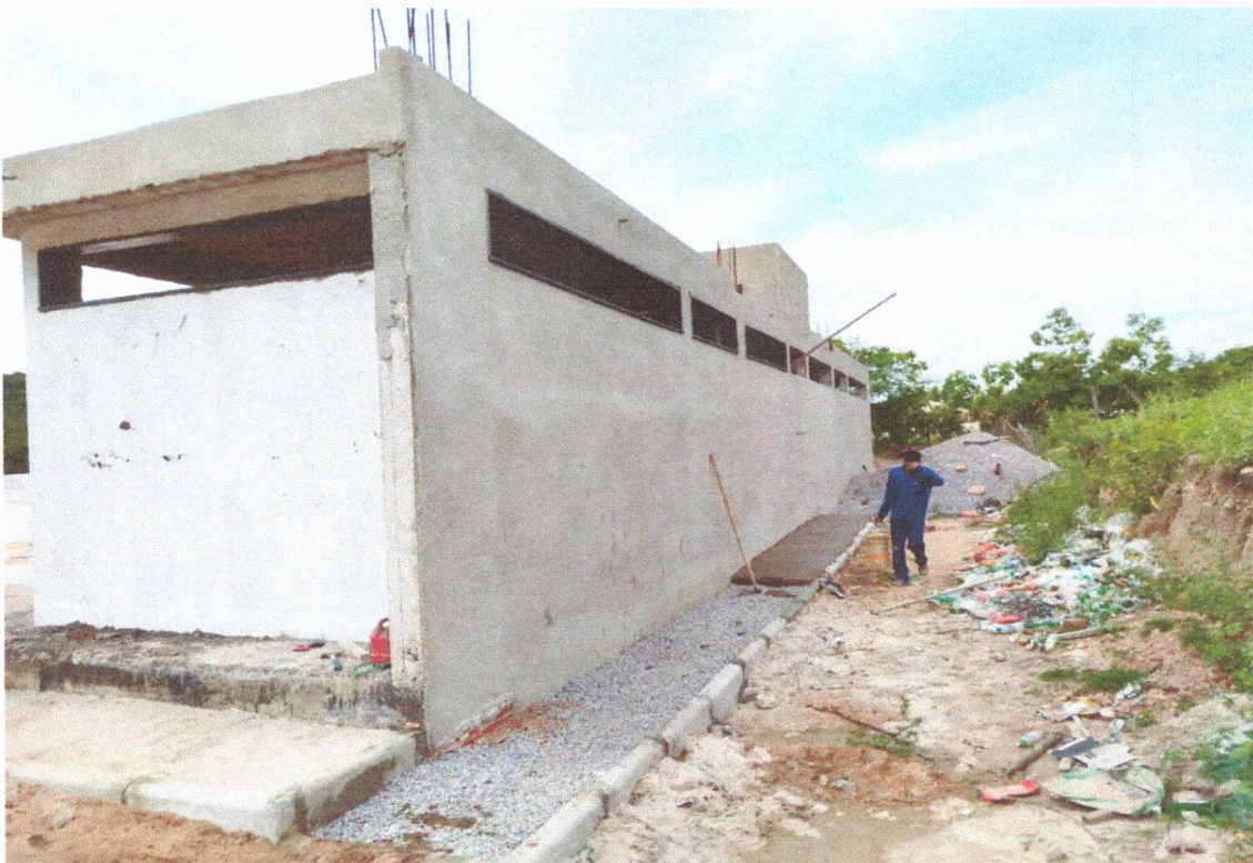
Anexo 05: Quadra poliesportiva do sítio Cachoeira de Minas em construção. Data: 05/04/2024
