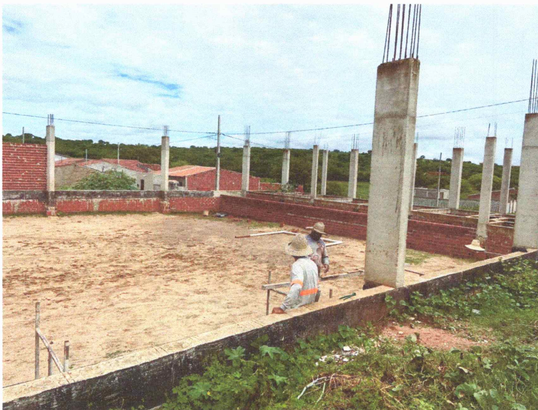
Anexo 01: Quadra poliesportiva do bairro São Francisco em construção. Data: 05/04/2024
