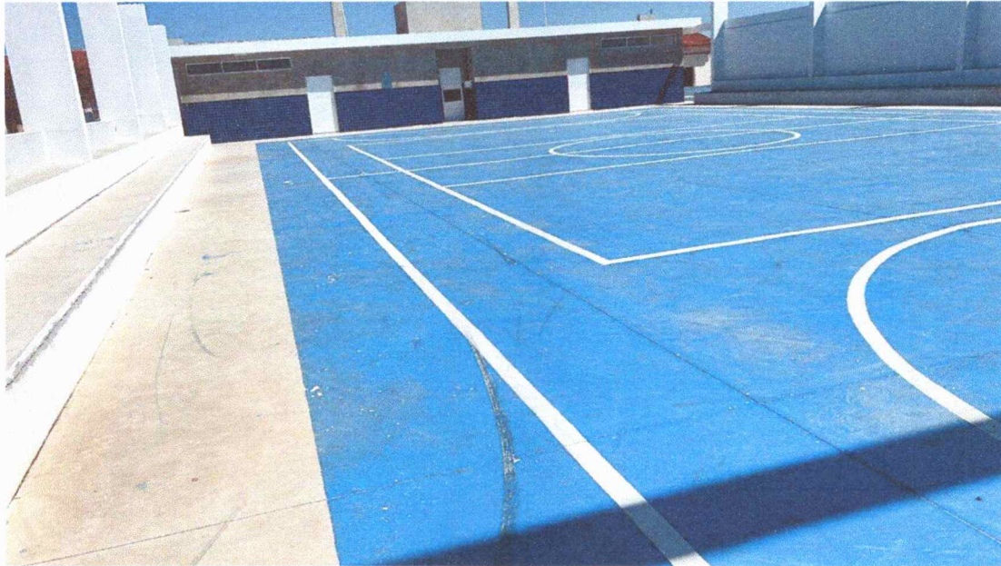
Anexo 04: Quadra poliesportiva do sítio Lagoa de São João em construção. Data: 05/04/2024
