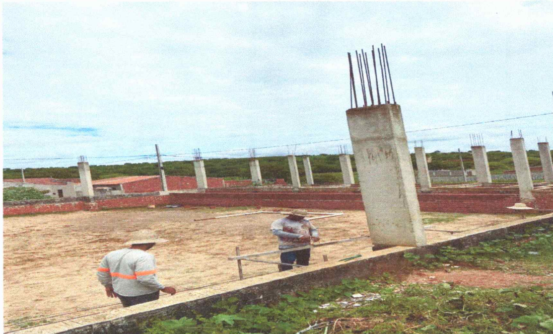
Anexo 02: Quadra poliesportiva do bairro São Francisco em construção. Data: 05/04/2024
