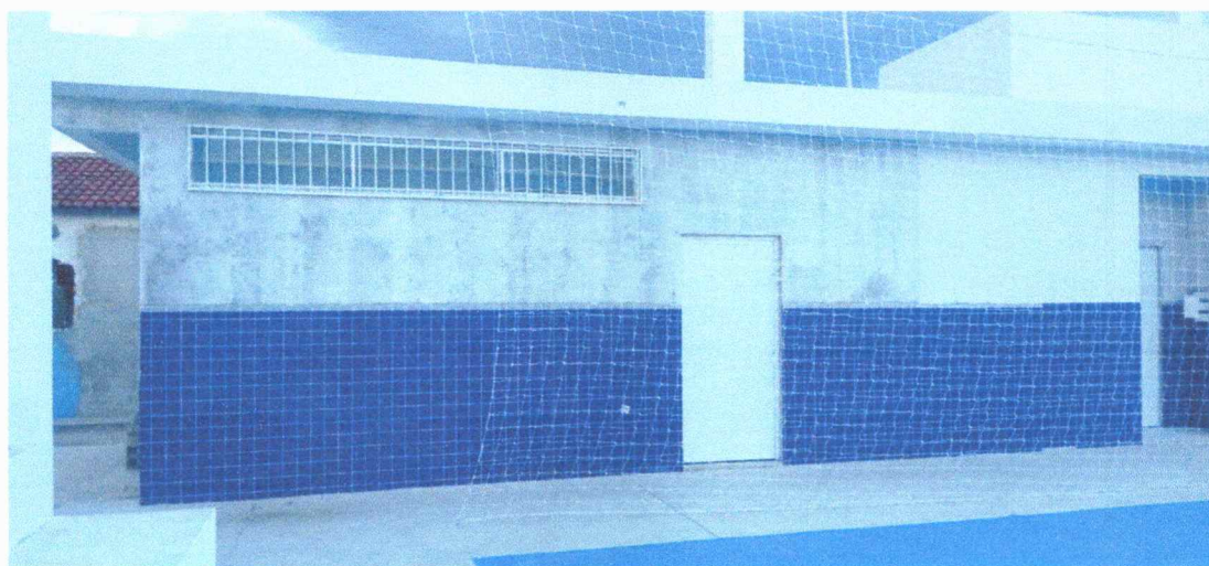
Anexo 03: Quadra poliesportiva do sitio Lagoa de São João em construção. Data: 05/04/2024
