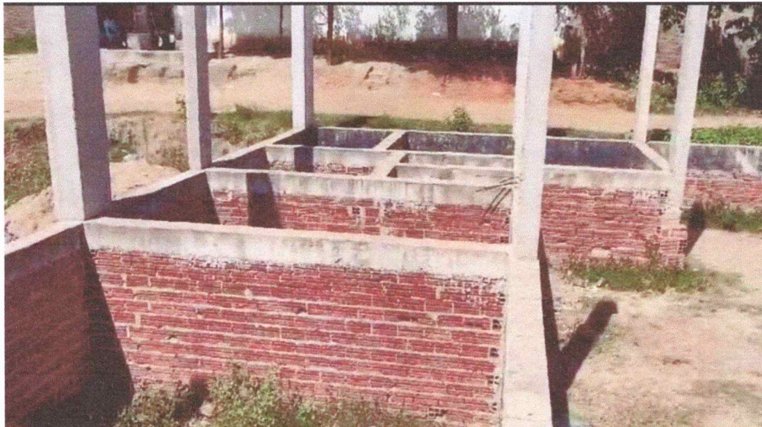
Anexo 04: Quadra poliesportiva do bairro São Francisco em construção. Data: 05/04/2024
